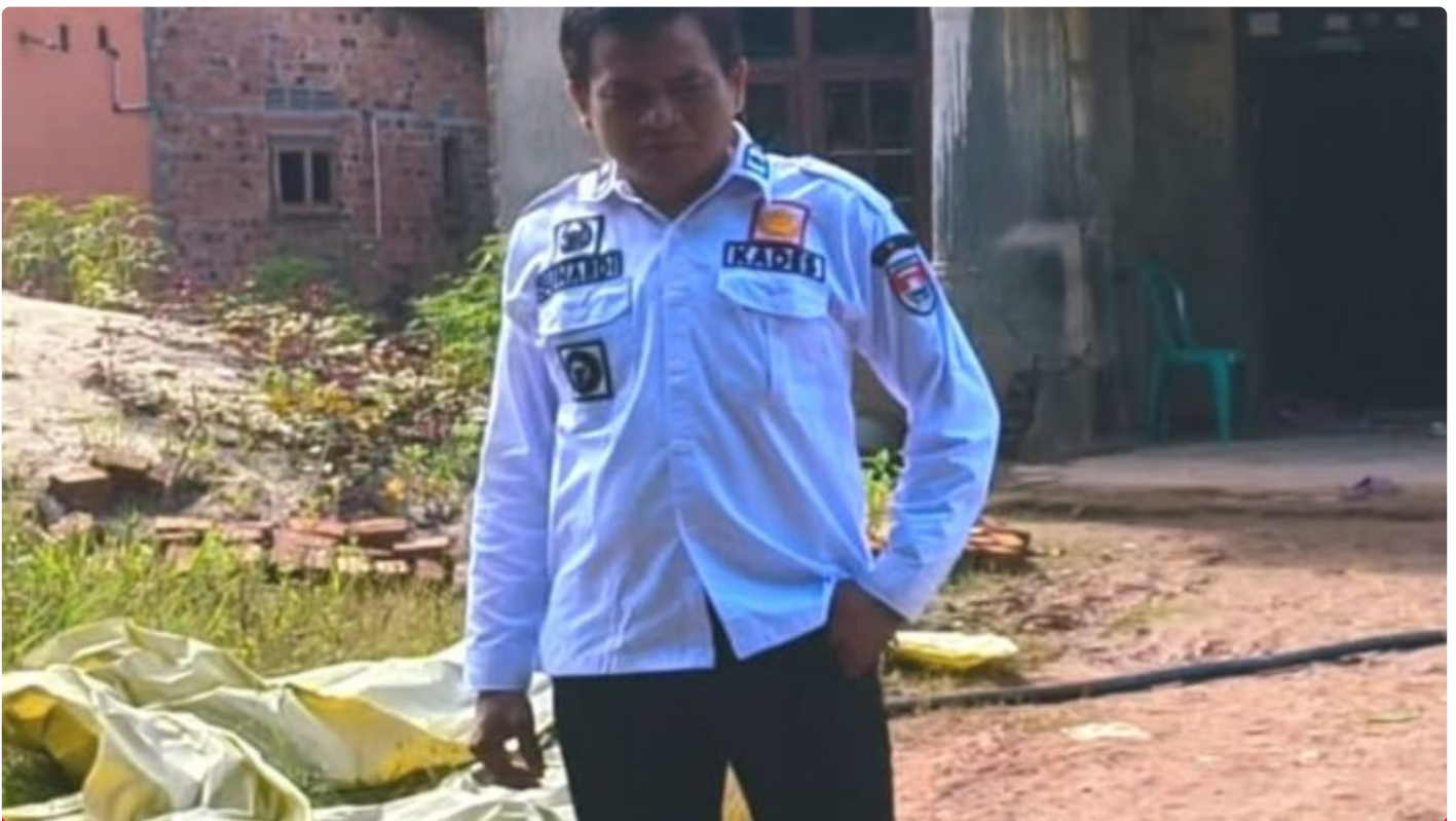
Kades Mekarsari Sunardi Mantau Pembangunan Jalan Rabat Beton
